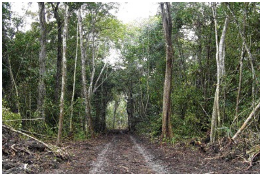
La construcción de camino y vías de arrastre produjo residuos que generaron un total de 1,94 tC/ha
