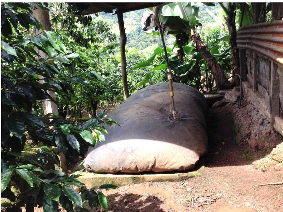
*Figura 13. Biodigestor instalado y funcionando en la propiedad de una familia de la comunidad.*
