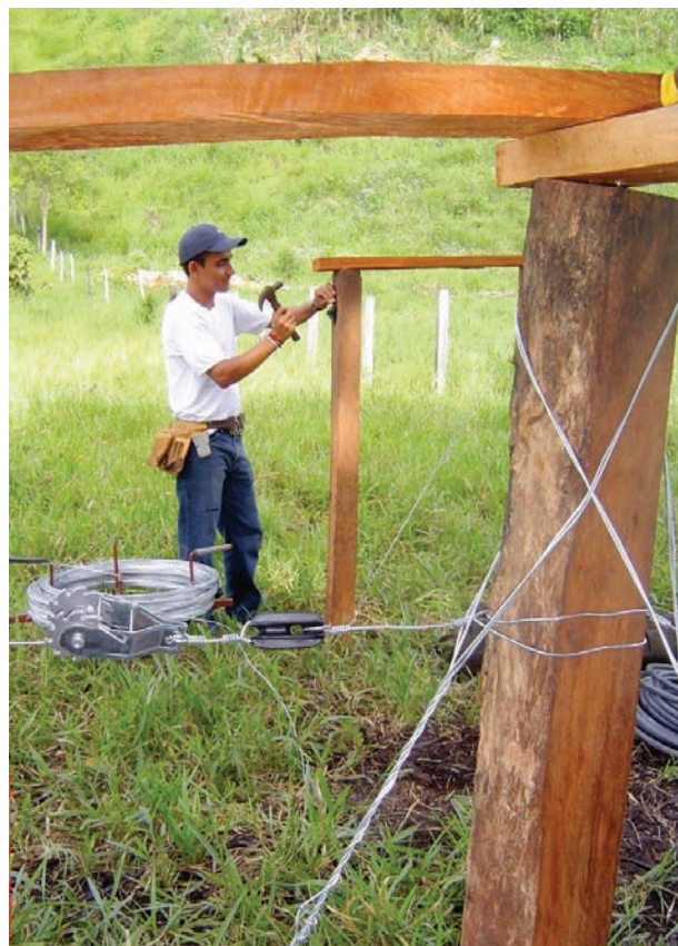
Foto 8. Anclaje de los postes esquineros con detalle de tensador Crédito: Danilo Pezo, CATIE
