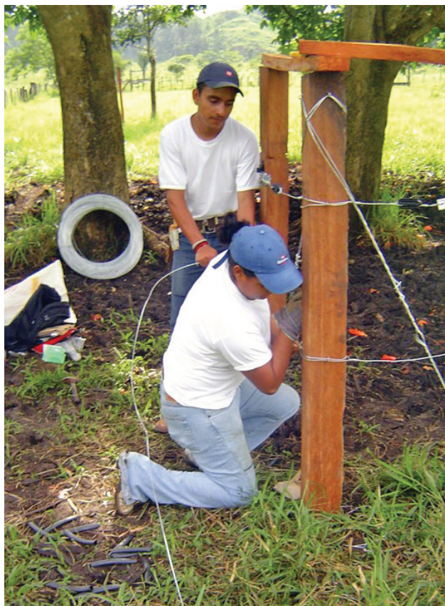
Foto 6. Instalación de postes esquineros Crédito: Danilo Pezo, CATIE
