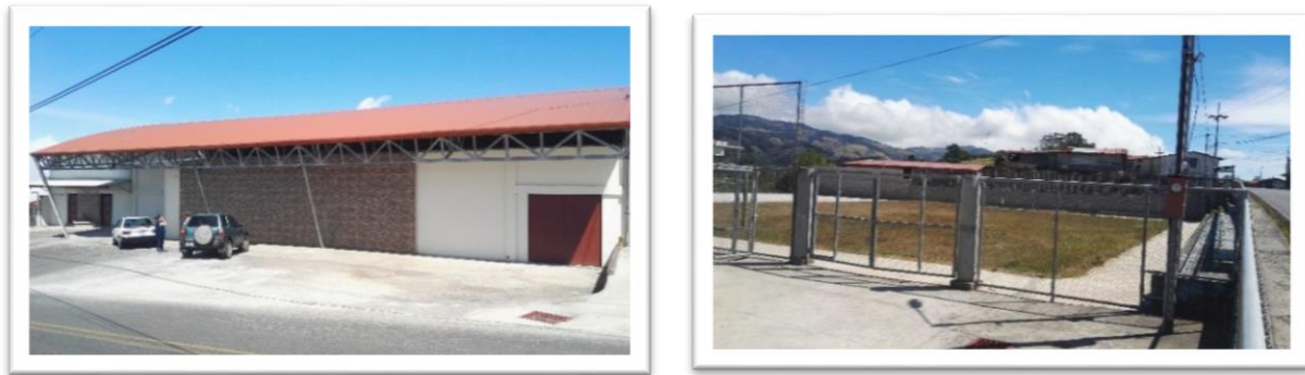
Figura 19. Salón comunal y cancha de deportes.
