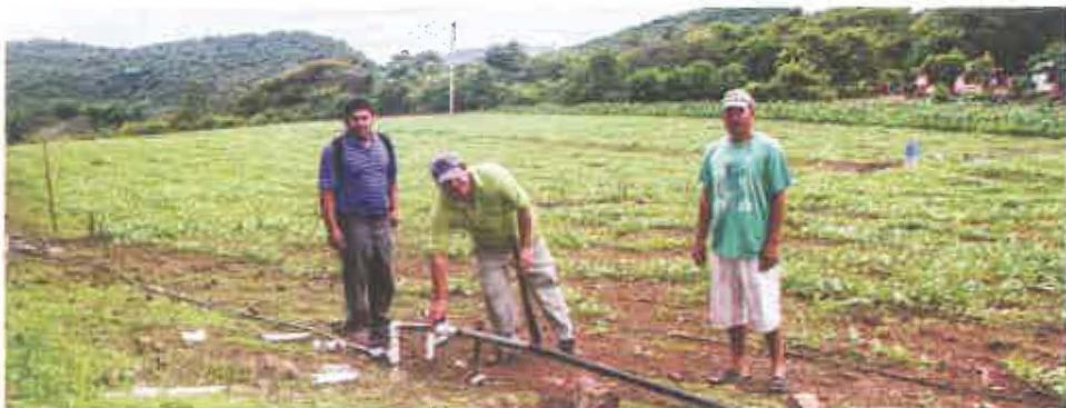
*Foto superior: línea de conducción. Sobre estas líneas, se muestra la tubería principal con la llave de paso. Al fondo, el área de cultivo con riego por goteo. Fotos: CATIE.*
