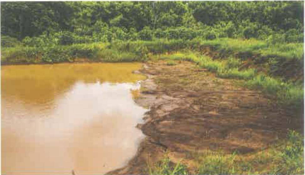
*Fallas en la construcción del reservorio asociadas con la presencia de suelos arenosos o franco arenosos terminan por dañar rápidamente la obra. Foto: CATIE.*
