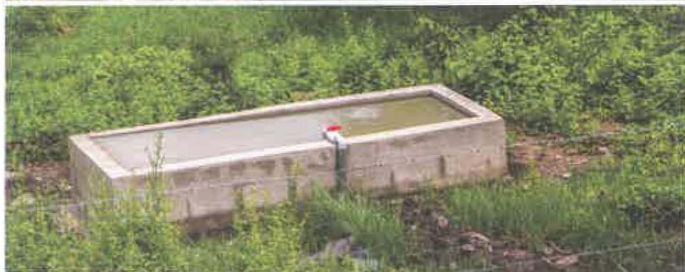
*La llave de paso o grifo es necesaria para controlar el volumen de agua en el reservorio. Abrevadero construido por el Proyecto Adaptación de la Agricultura al Cambio Climático a través de la Cosecha de Agua en Nicaragua. Fotos: CATIE.*
