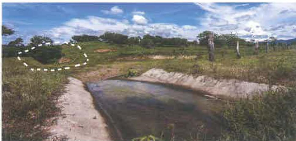
*Un diseño deficiente, como muestra la fotografía, convierte al vertedero o aliviadero en un canal de ingreso de agua al reservorio. Al fondo se observa la rotura de taludes. Foto: CATIE.*
