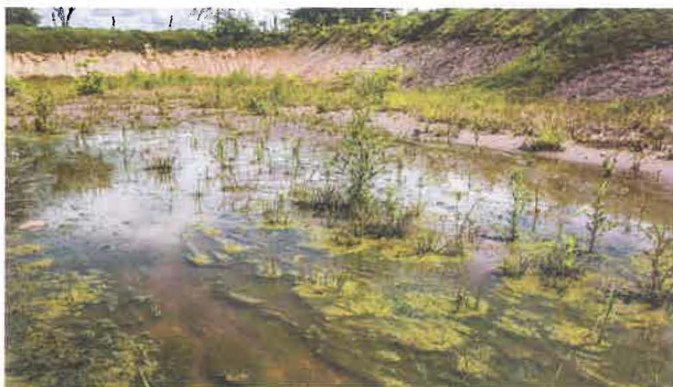
*Suelos porosos y permeables, sumados a la deficiente impermeabilización en el vaso del reservorio, ocasionan altos niveles de infiltración del agua de escorrentía. Foto: CATIE.*
