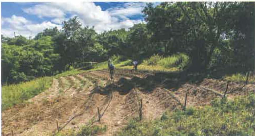
*Instalación del sistema de riego por goteo usando curvas a nivel en la finca del agricultor Concepción López, Mozonte, Nueva Segovia. Foto: CATIE.*
