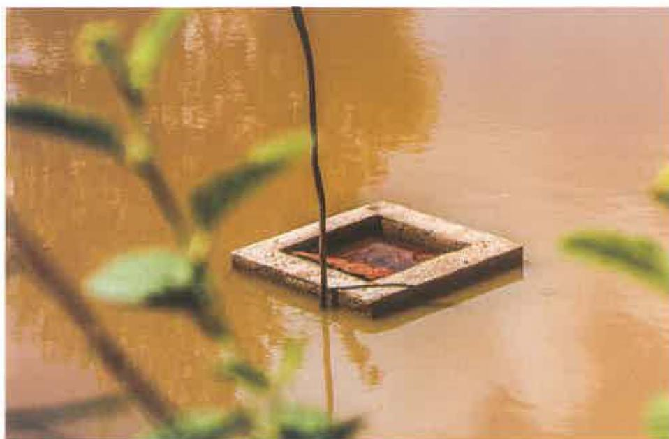
*Obra de toma desprotegida de la entrada de sedimentos y basura gruesa, como hojas o ramas que pueden obstruir la tubería de desagüe. Foto: CATIE.*
