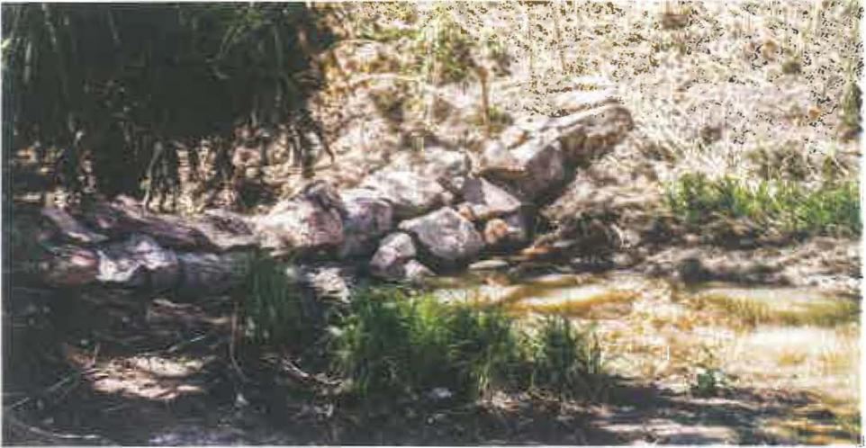
*Los muros de piedra o barreras muertas actúan como disipadores de energía, reduciendo la velocidad de la escorrentía que ingresa directamente al reservorio. Foto: CATIE.*
