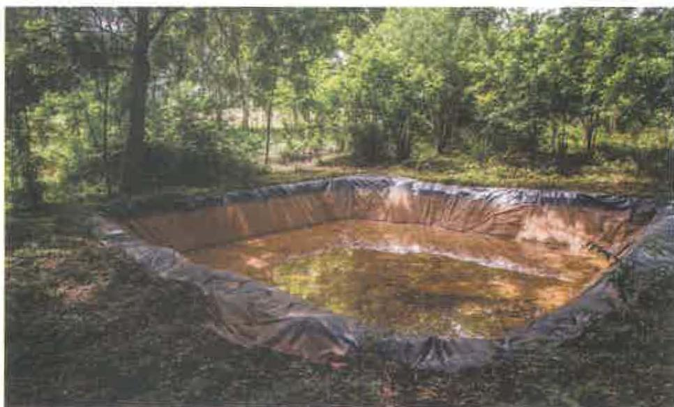
*La ausencia de obras de retención de sedimentos en el área de recarga y la falta de limpieza del reservorio dañan rápidamente la estructura. Foto: CATIE.*
