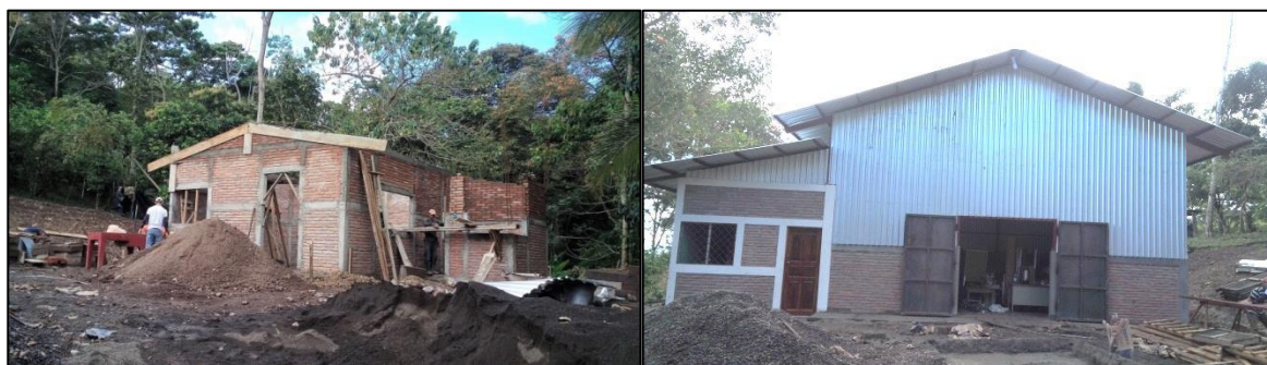
Figura 17 Construcción de Instalaciones de Acopio y Secado de café, gestionada con el proyecto NICADAPTA por COMULACS R.L. Fuente: Propia.
