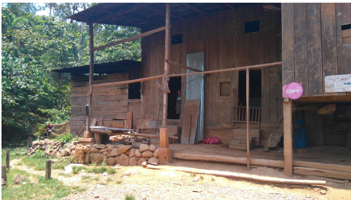
Figura 17: Casa de cedro real, en Waslala. Posee fuerte valor simbólico, además de su utilidad para la construcción.
