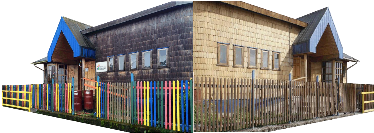
Figura 30. Recuperación y conservación de la fachada de tejuela de ciprés de las Guaitecas (antes y después de la intervención social)
