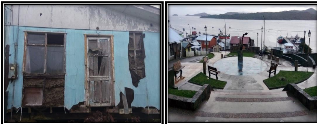
Figura 10. Vivienda en mal estado y escaso uso de plaza pública
