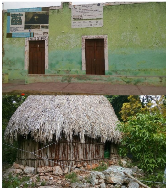
Figura 10. Casa mampostería y de bajareque
