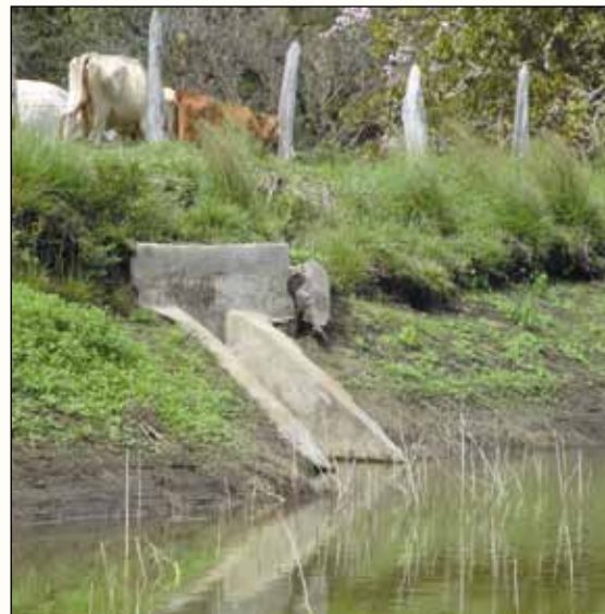
La salida del agua hacia los bebederos es construida con concreto, implicando altos costos.
