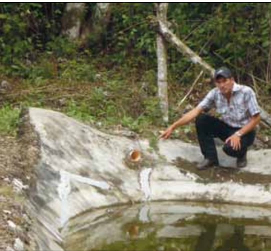
Una aguada impermeabilizada con "terracedo". En la foto inferior nótese el vertedero para descargar excesos de agua.
