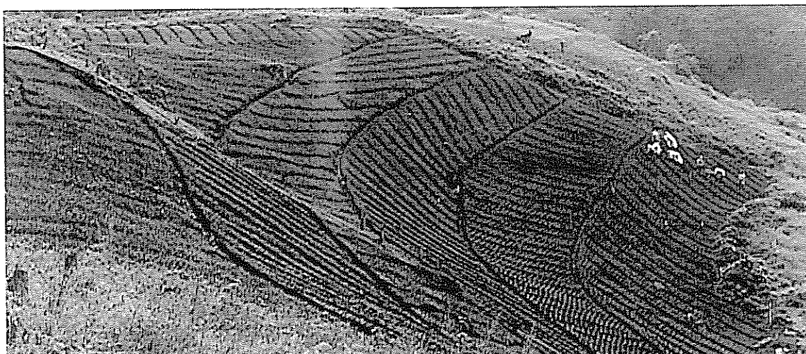
Las acequias de ladera son una de las herramientas utilizadas para el control de la erosión en cuencas para la producción hidroeléctrica en Panamá (Foto I. Victoria)
