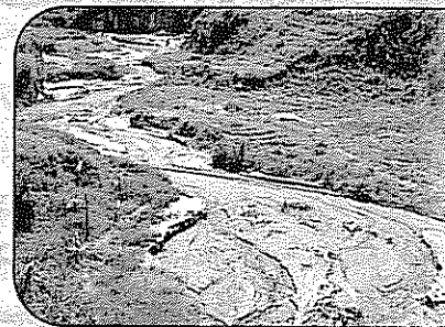
El mal manejo de la microcuenca del río Las Cañas es uno de los principales responsables del proceso de erosión y sedimentación del embalse hidroeléctrico Cerrón grande en el río Lempa (Foto J. Faustino).
