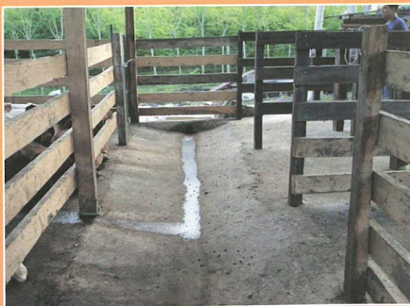
La cuneta para el drenaje
