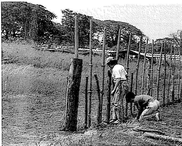
A la hora de establecer una cerca viva, determine un espaciamiento uniforme entre estacas, realice hoyos profundos y cortes en la parte apical (bisel) y basal (recto). En este caso se dejó un metro de espaciamiento entre estacas. (Fotografía A. Otárola).
