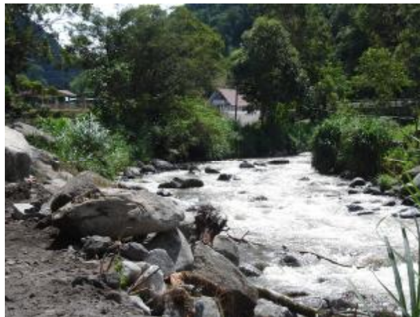
Figura 15 Foto del sector de Bambito, donde se muestra la falta de obras destinadas a la reducción del riesgo.
