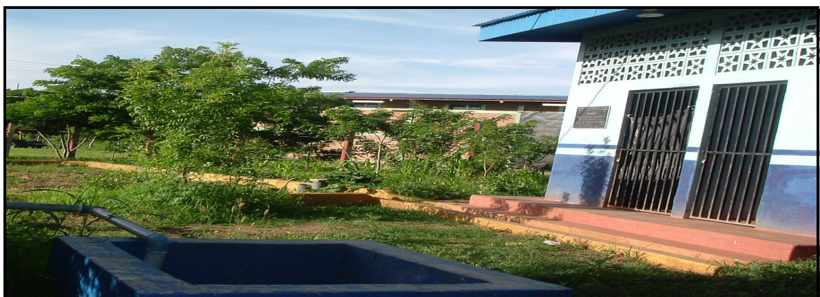
Figura 12. Sistema de abastecimiento de agua comunidad Uniles, bombeo eléctrico.
