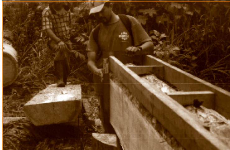
Foto 9.10 Acomodo de codal y escuadras para realizar el segundo corte. Se observa el primer corte en posición vertical.
