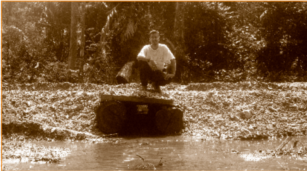
Foto 4.3 Alcantarilla ubicada en el paso de un curso de agua. Layasiksa, RAAN, Nicaragua. El material de construcción proviene de madera de deshecho de una industria de plywood.
