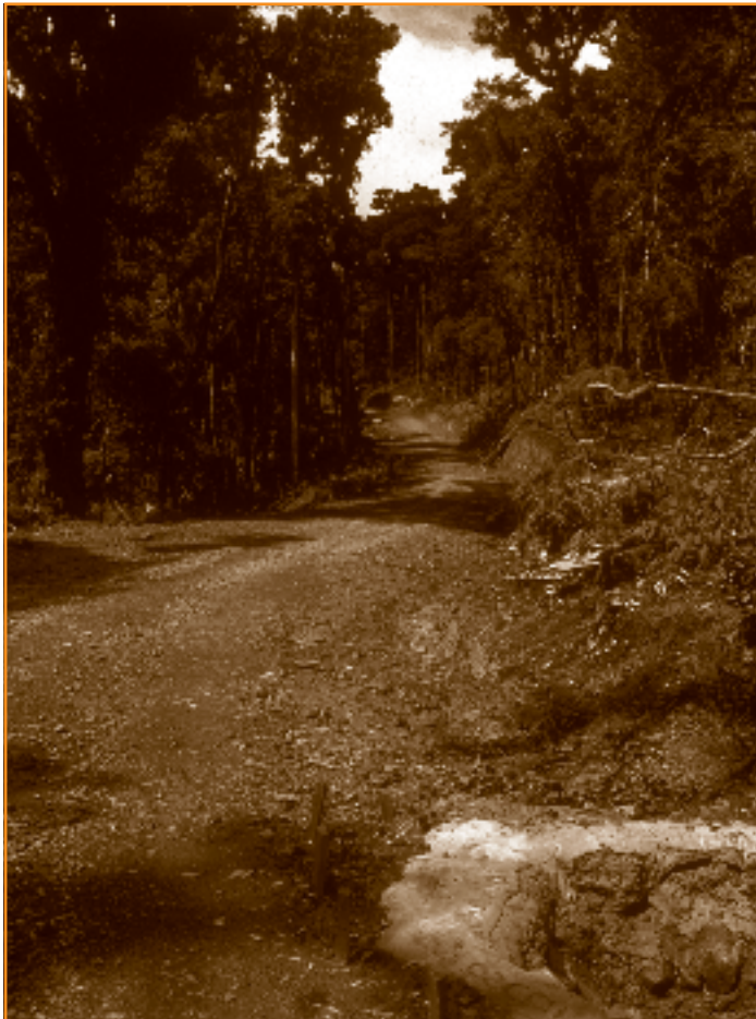
Foto 4.2 Camino principal con sistema de drenaje en Villa Mills, Cordillera de Talamanca, Costa Rica. Nótese la boca de la alcantarilla, la cuneta y el bombeo del camino.
