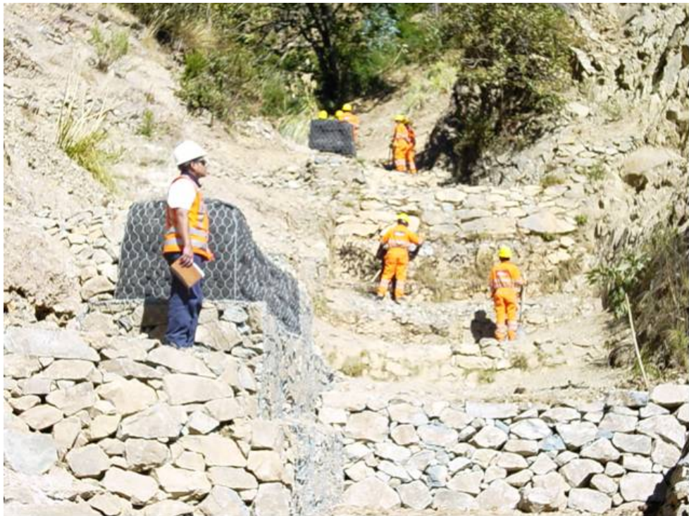
Foto 10. Trabajos de estabilización de cauce de quebradas
