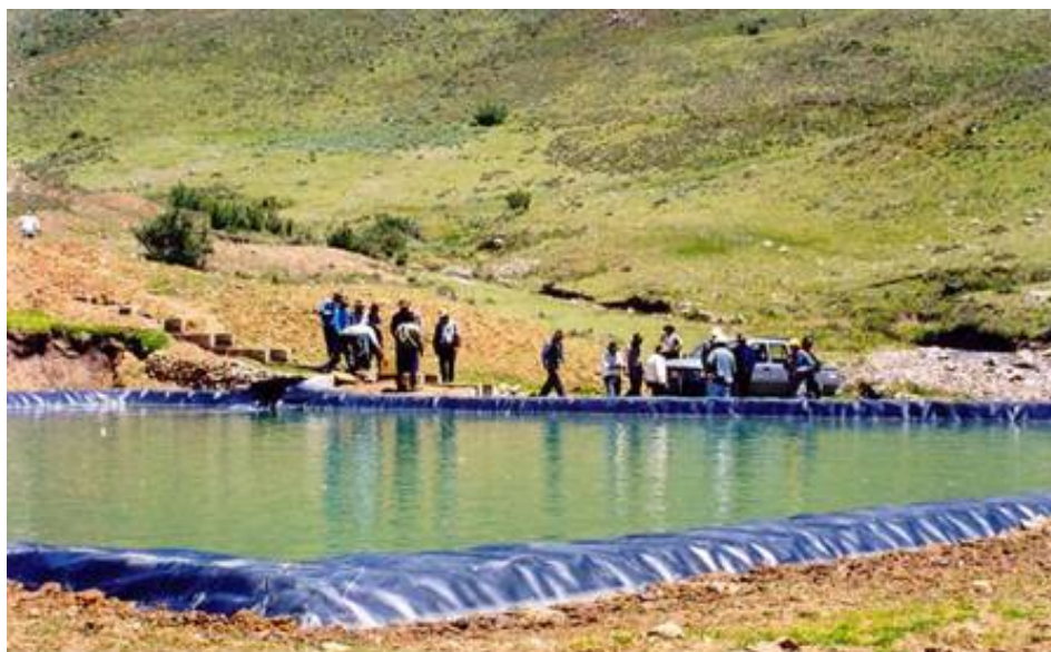
Foto 2. Construcción de reservorio para almacenamiento de agua para las comunidades
