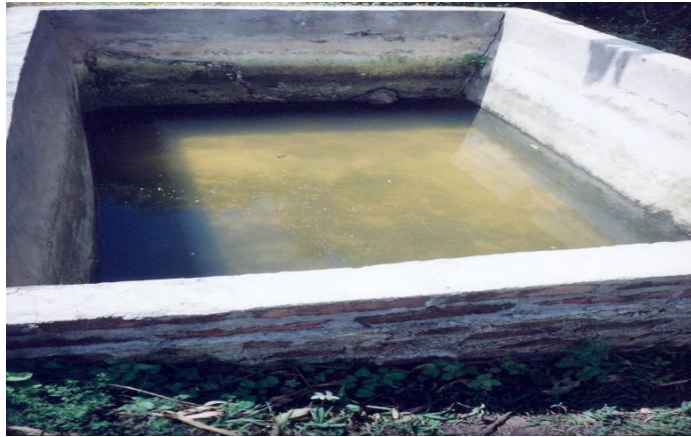
Figura 15. Piletas de concreto con bloque de arcilla quemado, vista interior
