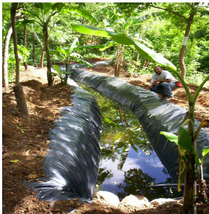
Figura 68. Zanja de almacenamiento funcionando
