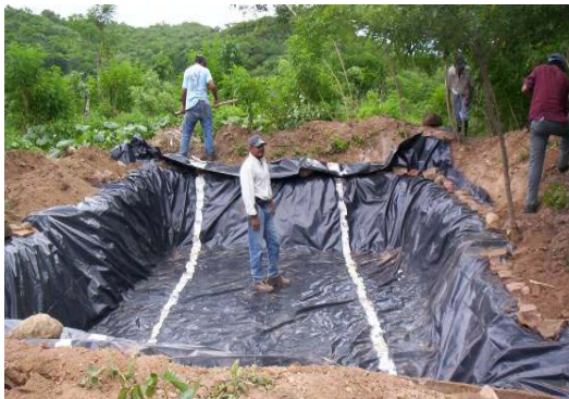
Figura 81. Revestimiento con polietileno
