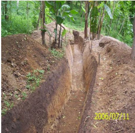
Figura 22. Excavación de zanja
