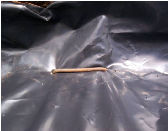
Figura 71. Prensado con grapa metálica
