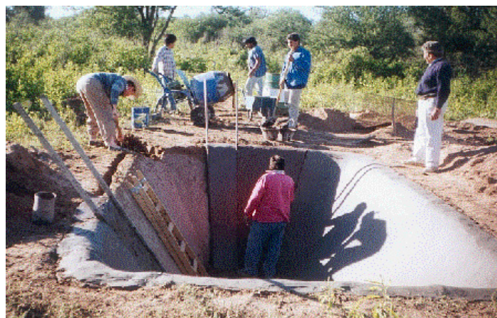
Figura 24. Construcción de aljibe revestido con concreto
