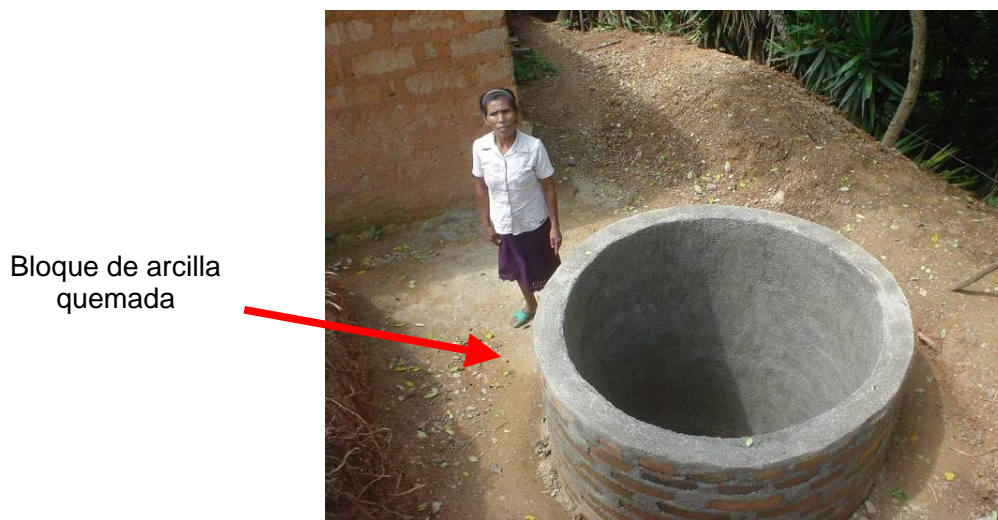
Figura 21. Pozo cisterna construido con bloque de arcilla quemada
