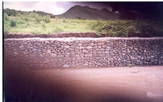
Figura 30. Dique con gaviones en quebrada
