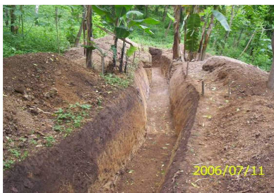
Figura 65. Conformación de zanja con talud
