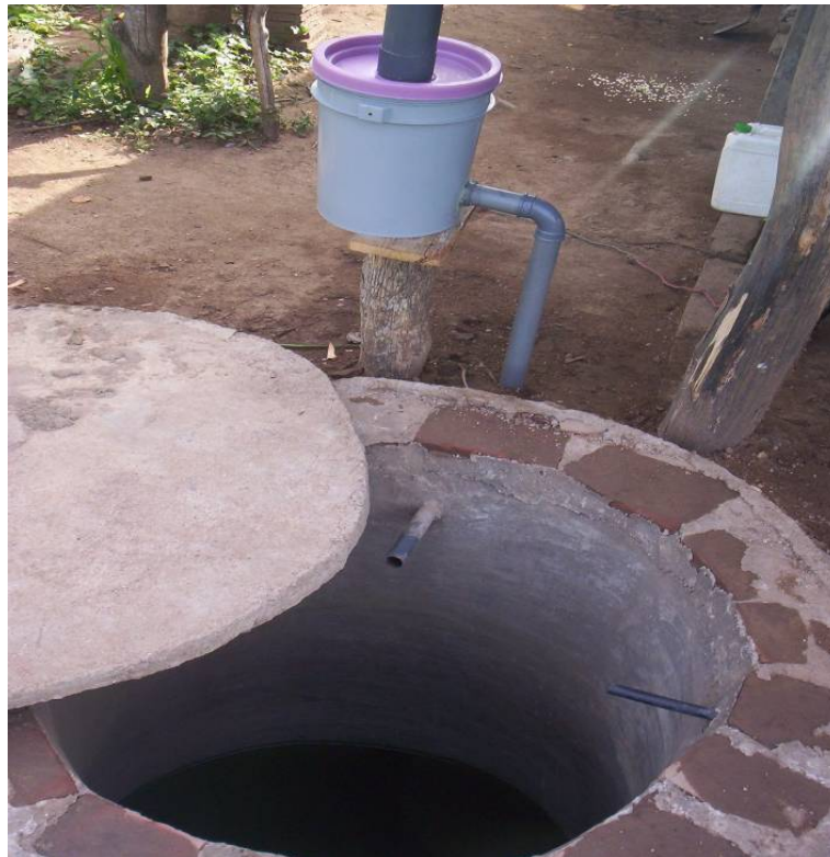
Figura 83. Instalación de filtro plástico y cisterna
