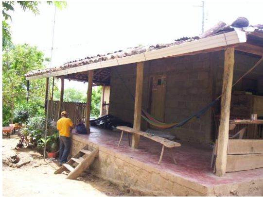
Figura 66. Área de captación y canal plástico
