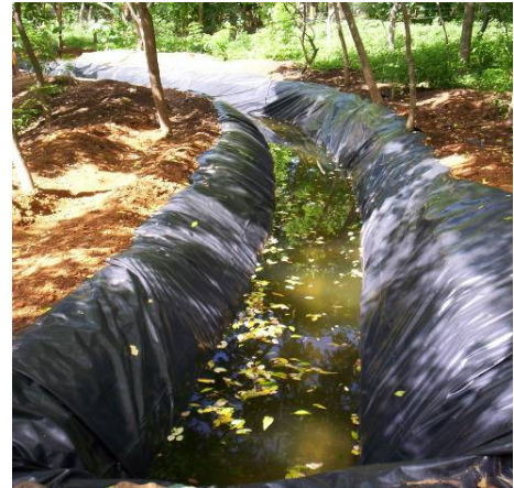
Figura 23. Zanja de almacenamiento revestida
