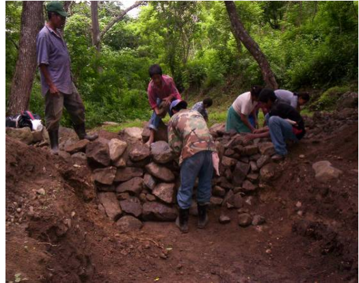
Figura 75. Construcción de dique con piedra
