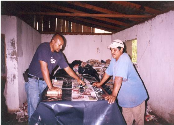
Figura 88. Pegado de láminas de polietileno
