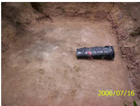
Figura 25. Excavación y base del aljibe Figura 26. Aljibe revestido con polietileno
