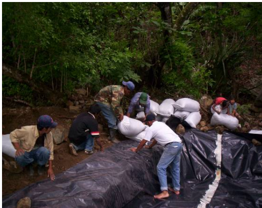
Figura 76. Revestimiento con polietileno
