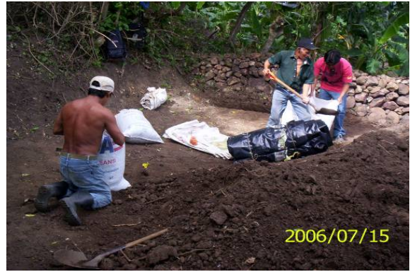
Figura 70. Llenado de sacos con tierra
