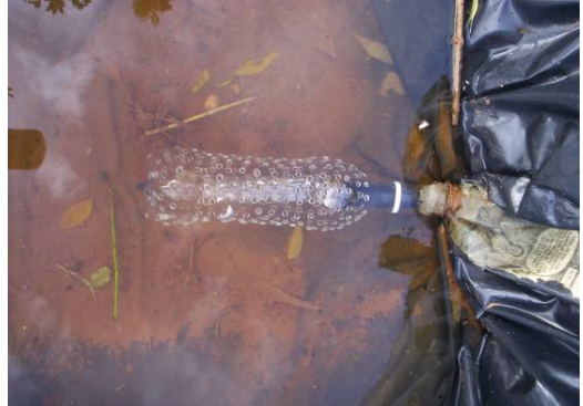
Figura 82. Área de descargue con filtro
