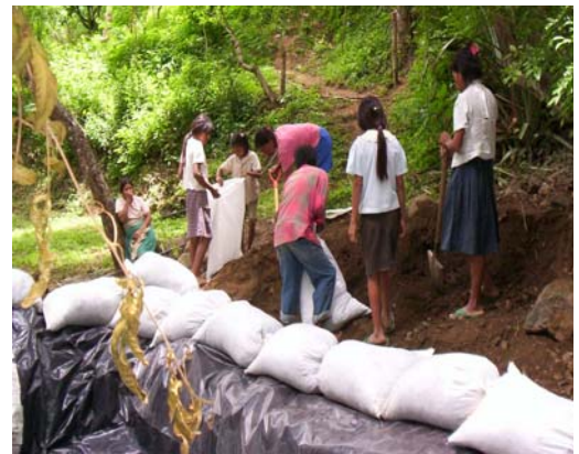
Figura 77. Llenado de sacos con tierra
