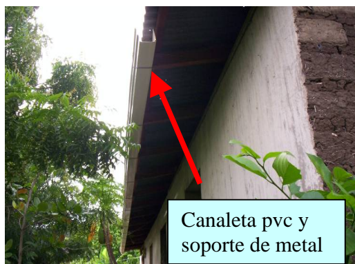
Figura 42. Canaleta plástico instalado
