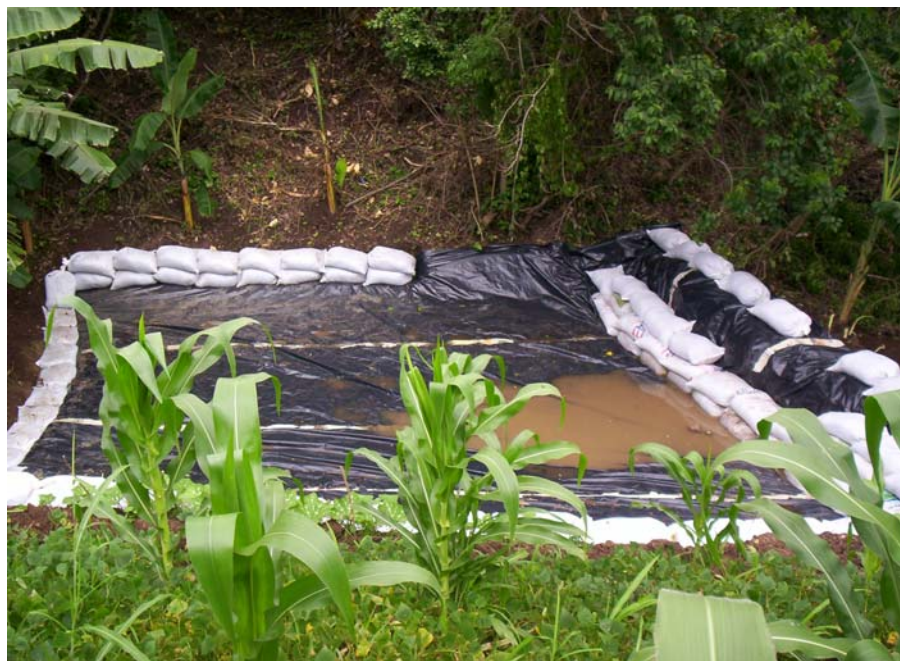
Figura 73. Microrepresa revestida con polietileno funcionando
