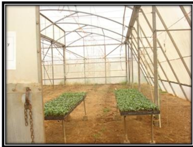
Figura 10. Casa de vegetación tipo multitúnel asimétrico
