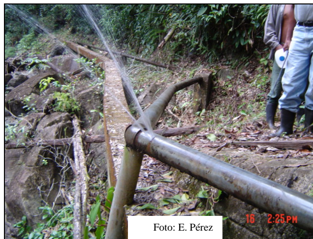
Fotografía 23. Sistema de aireadores de la aldea Sahilá, microcuenca del Río Caquijá, Izabal, Guatemala.
