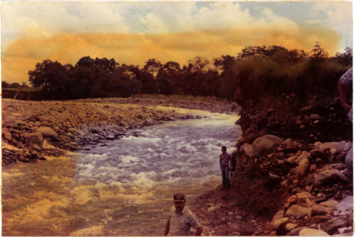
#5 Socavación margen izquierda; aguas arriba puente La Guinea
