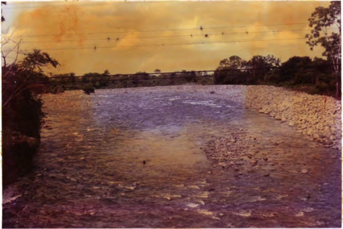
#7 Obras de protección de márgenes construidas por la PTP, aguas abajo de puente La Guinea, margen derecha
