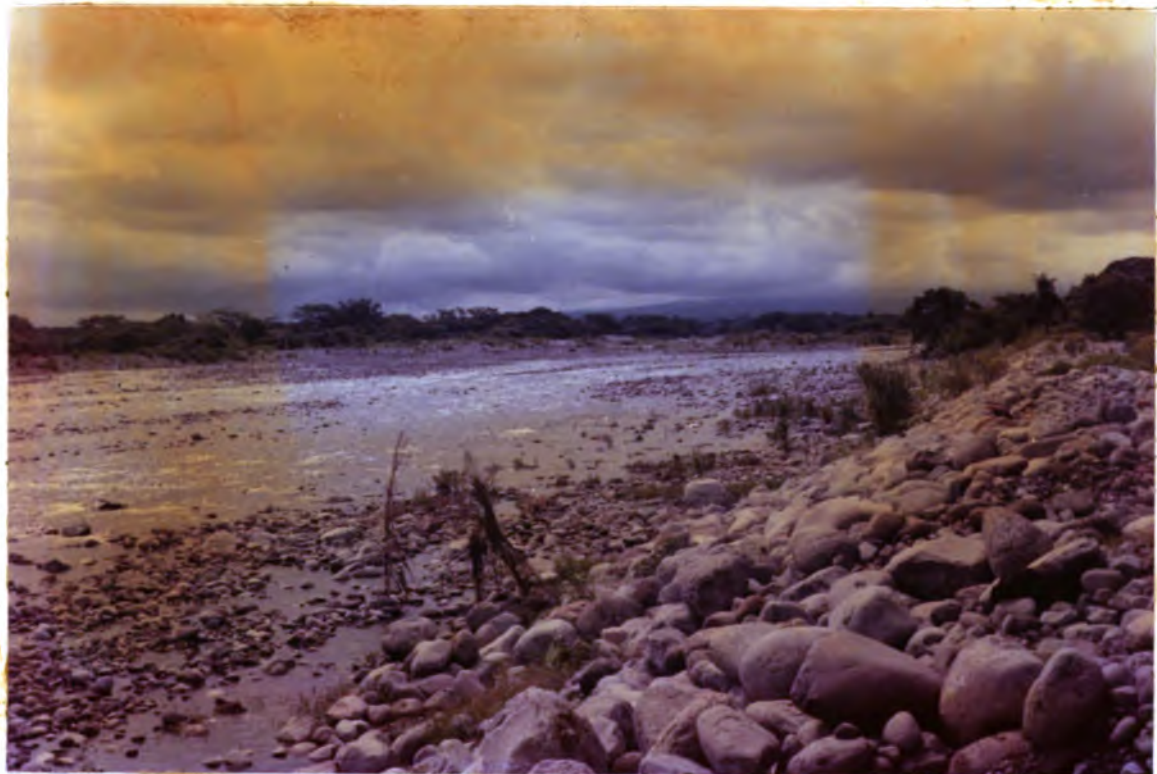
#8 Obras de protección en ambas márgenes cerca del cruce del oleoducto de PTP
