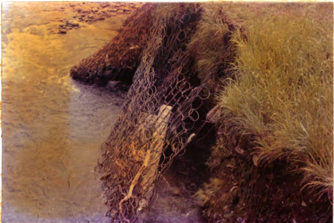
#10 Obra de protección del estribo izquierdo del puente La Guinea
