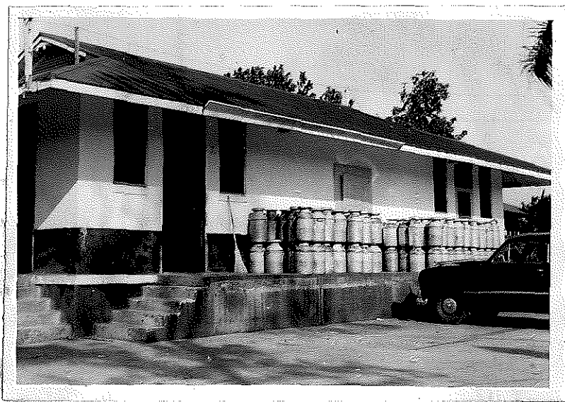
Vista de la cremería. Lado izquierdo: planta de enfriamiento; parte central: re- frigeradora; lado derecho: laboratorio.
