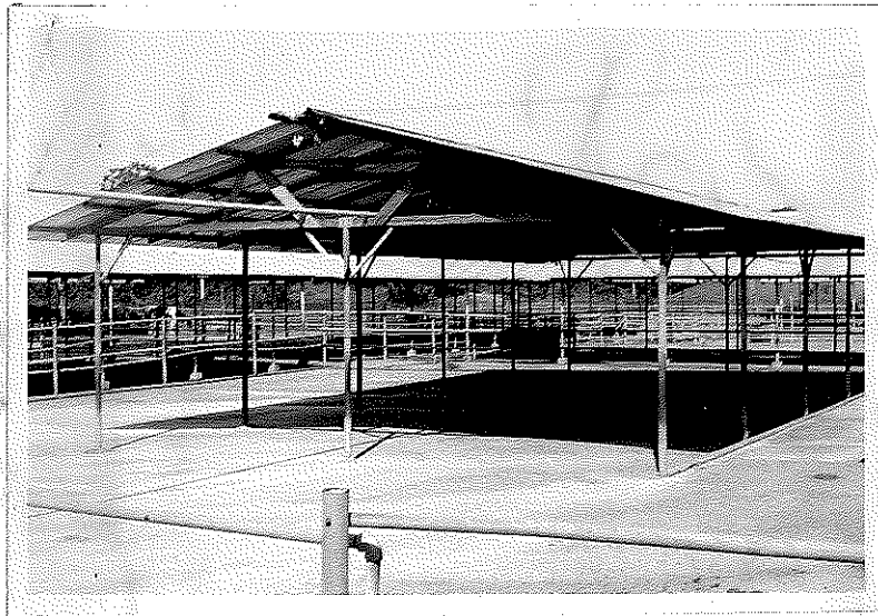
Patio de ejercicio en donde permanecen los animales mientras no están en el local de ordeño. Obsérvese el piso de cemento.
