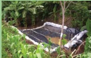
Esta obra puede captar agua por escorrentía y por precipitación recogida; o sea, el agua que cae directamente en el estanque. Se aprovecha la forma natural del cauce; solo se excava un poco donde haga falta para acomodar y nivelar la tierra y luego construir el dique de retención de aproximadamente un metro de alto. En los laterales de la microrrepresa, el polietileno se prensa con grapas metálicas para que el plástico no se deslice.
