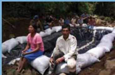
Esta obra, al igual que la anterior, puede captar agua de la quebrada y por precipitación recogida. Aquí también se aprovechan las condiciones naturales del cauce; solo se excavó un metro para conformar taludes, nivelar y construir el dique en dirección transversal a la dirección del agua, con una altura aproximada de un metro.
