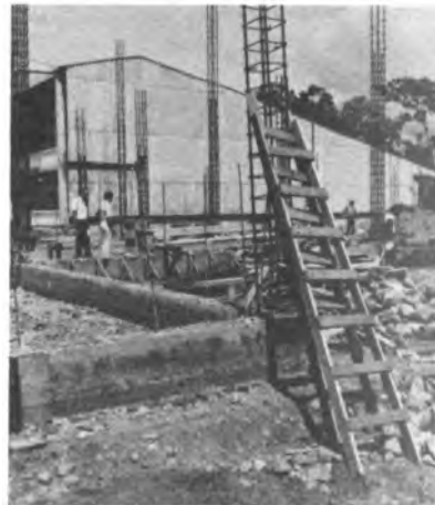
Construcción del edificio que albergará la Biblioteca Conmemorativa Orton. La financiación de esta edificación se lleva a cabo con el aporte financiero de la ODA.
