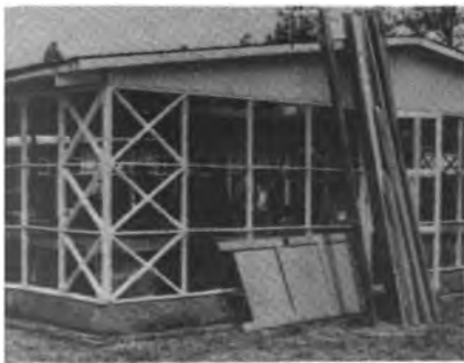
Reconstrucción de invernaderos.
