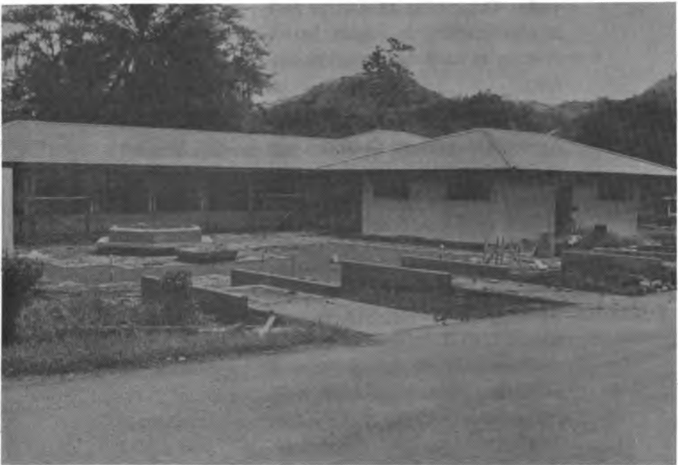
Las instalaciones del Centro de Cómputo están en su fase final de construcción; ahí se desarrollarán importantes actividades como el establecimiento de CATIENET, una Red que unirá electrónicamente al Centro con varios países del área.
