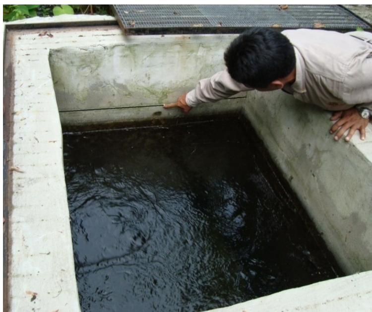
Figura 7. Línea que muestra el nivel de agua en condiciones normales
