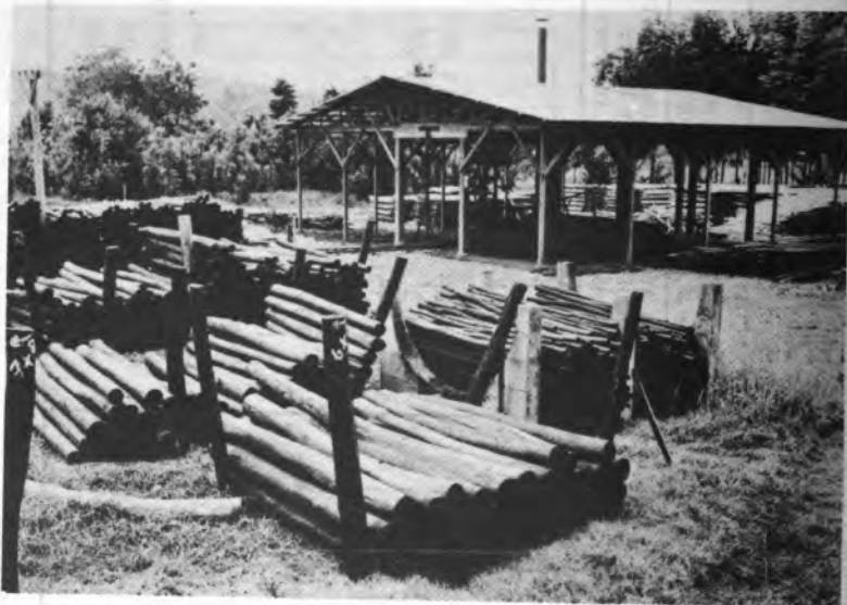
Figura 9.2c.: Postes tratados de Eucalyptus deglupta en dimensiones variables. Planta de tratamiento de postes del Centro Agrícola Cantonal de Turrialba, Costa Rica. (1979).
