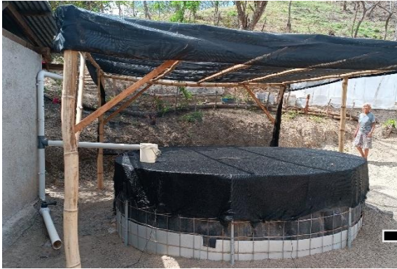
a) Cosecha de agua de techo con TTZ. Municipio Totogalpa-Madríz
