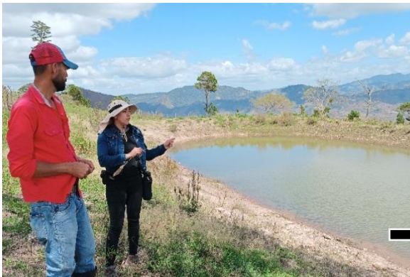
c) Reservorio para almacenar agua de lluvia. Comunidad El Bramadero, Condega- Estelí.
