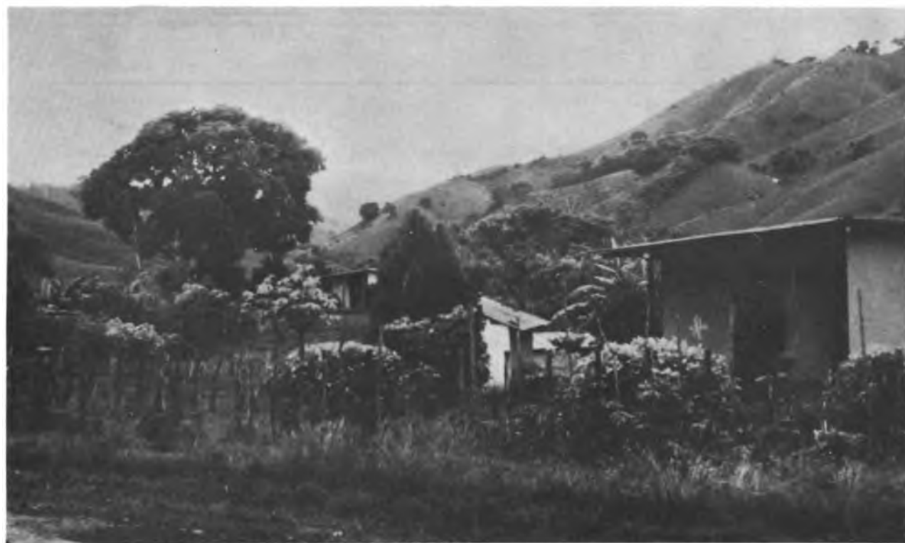
FIGURA 8. Viviendas de block y zinc. Los Santos.
