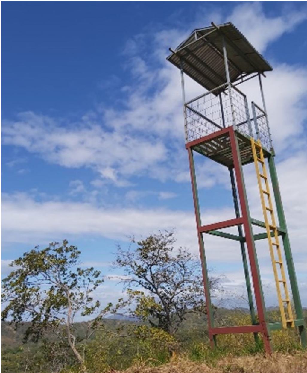
Figura 15. Torre de avistamiento de la Brigada de Bomberos Forestales de Tamarindo, región Chorotega, Costa Rica.
