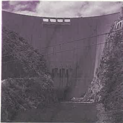
La presa vista desde aguas abajo.
