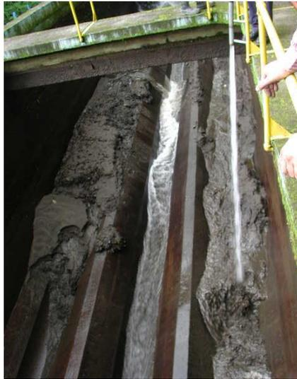
**Figura 7.** Sedimentos En la Planta Potabilizadora del AyA.
