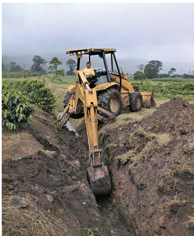
Figura 9. Mejoras del drenaje en límites exteriores de las parcelas del ensayo de largo plazo en sistemas agroforestales con café, Turrialba, Costa Rica, julio 2002. Foto: E. de M. Virginio Filho.
