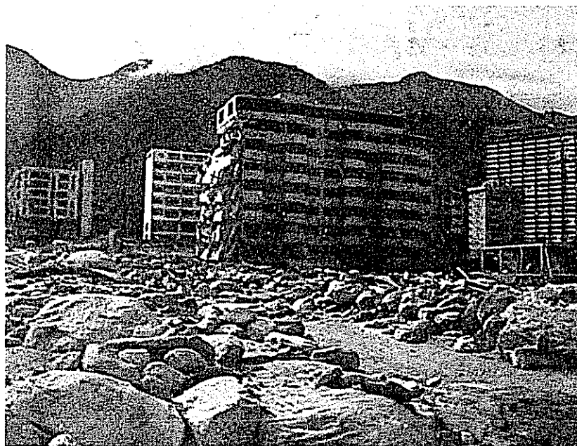
Daños típicos por flujo de materiales predominantemente rocoso en las partes bajas de las cuencas (Sector Los Corales)
