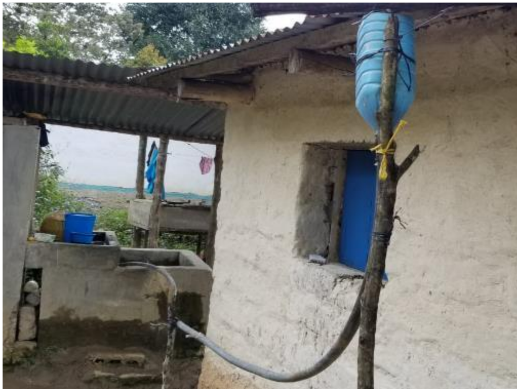
Figura 6. Fotografía de sistema artesanal de recolección de aguas lluvias Fuente: fotografía propia.
