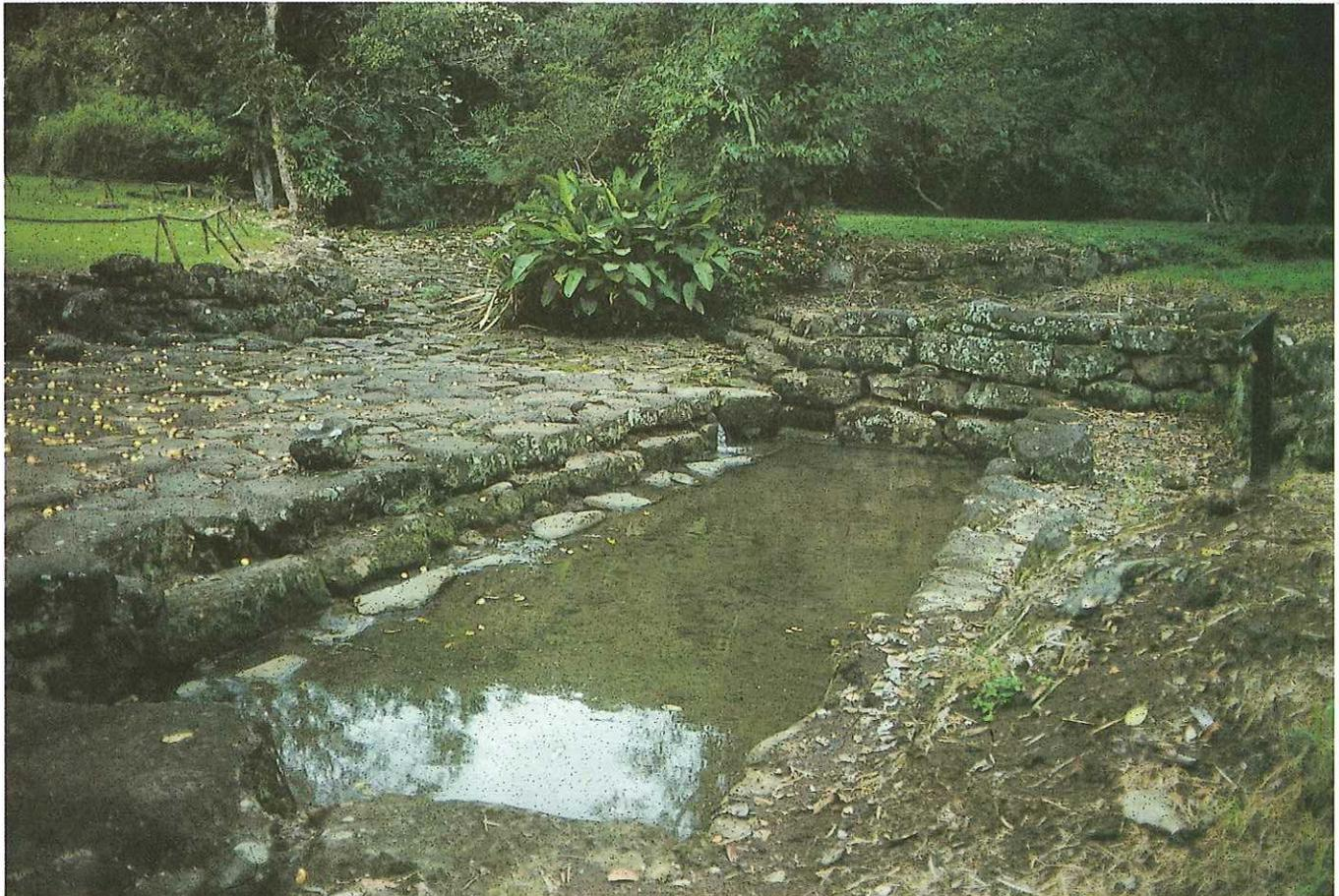
mente, el agua sobrante es evacuada de dicha área a través de un vertedero en forma de "V" que permite controlar el nivel del agua y liberar sólo aquella que rebalsa la capacidad del tanque. Esta recorre por debajo de un puente de piedra formada por grandes cantos mayores a dos metros de longitud y finalmente es liberada a un canal de desagüe natural.
