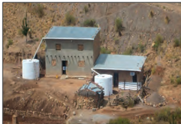
Figura 4. El establecimiento de tanques en esta zona de Bolivia permite almacenar el agua de lluvia recolectada de los techos para su uso durante 3 a 5 meses de sequía absoluta (Foto de Gertner et al. 2016).
