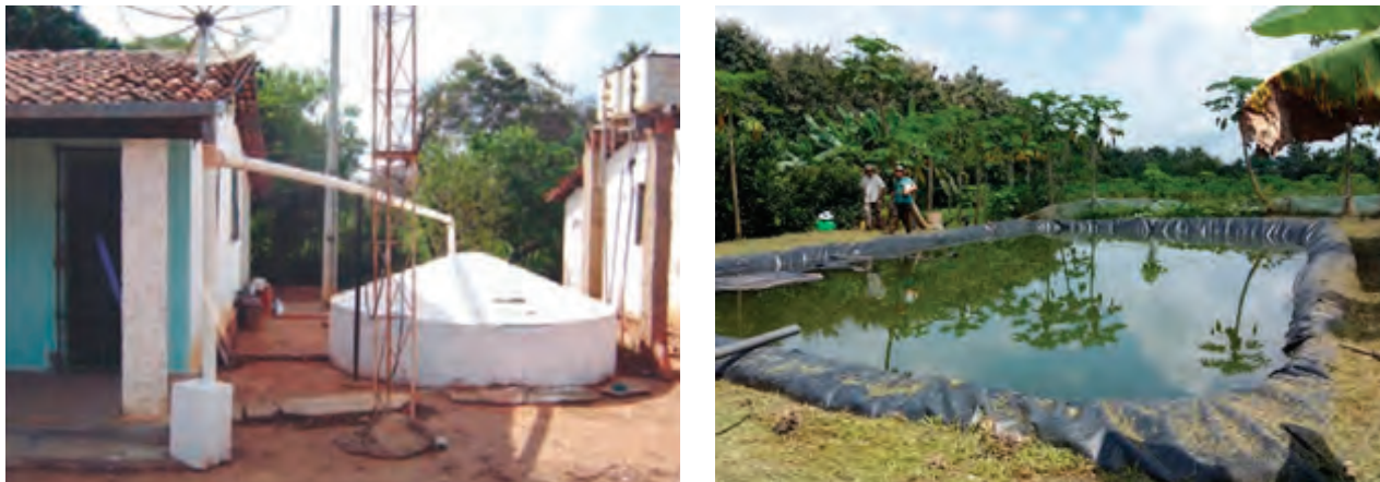
Figura 3. Dos ejemplos de cosecha y uso de agua de lluvia. Izquierda: Cosecha de agua de lluvia y almacenamiento en una cisterna de 16 m 3 en el NE de Brasil. Derecha: una laguna artificial, impermeabilizada con una geomembrana, para almacenar agua de lluvia de un techo con el fin de usarlo para regar una plantación de papaya orgánica en Costa Rica (Fuentes de fotos: Marcos J Vieira en FAO 2013 y RG Muschler).
