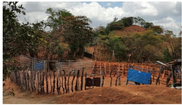
Foto: Construcción chutra y chute
