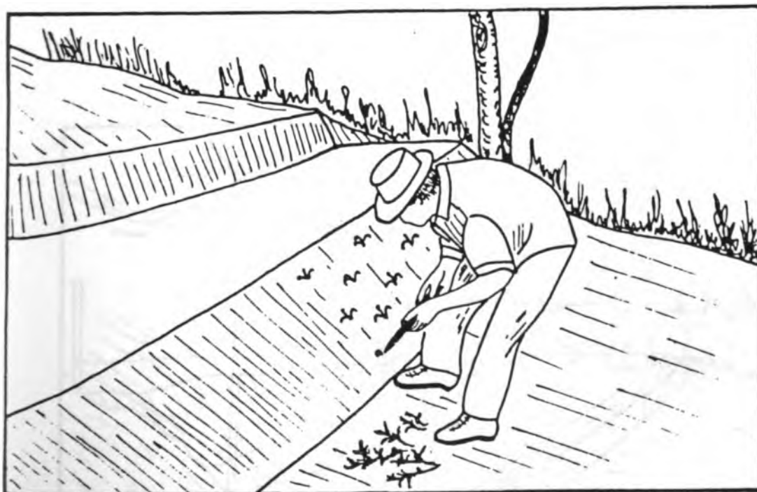
Siembra de grama en taludes
