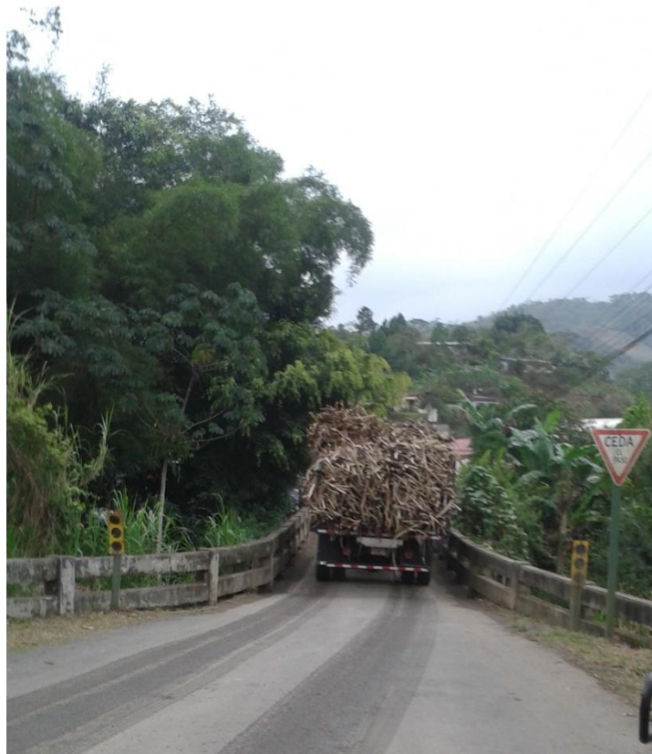
Figura 4. Paso de camiones cargados sobre el puente cercano a la escuela.
