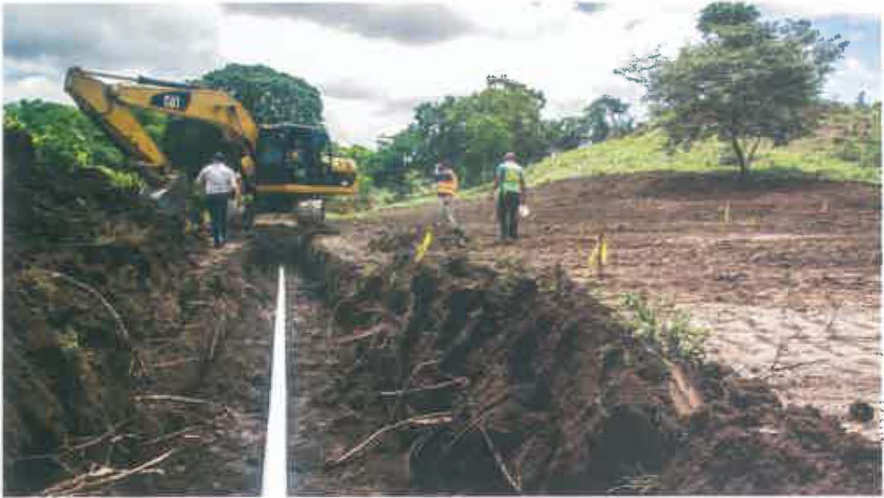
Compactación de la zanja para cubrir la tubería de agua. Foto: CATIE.
