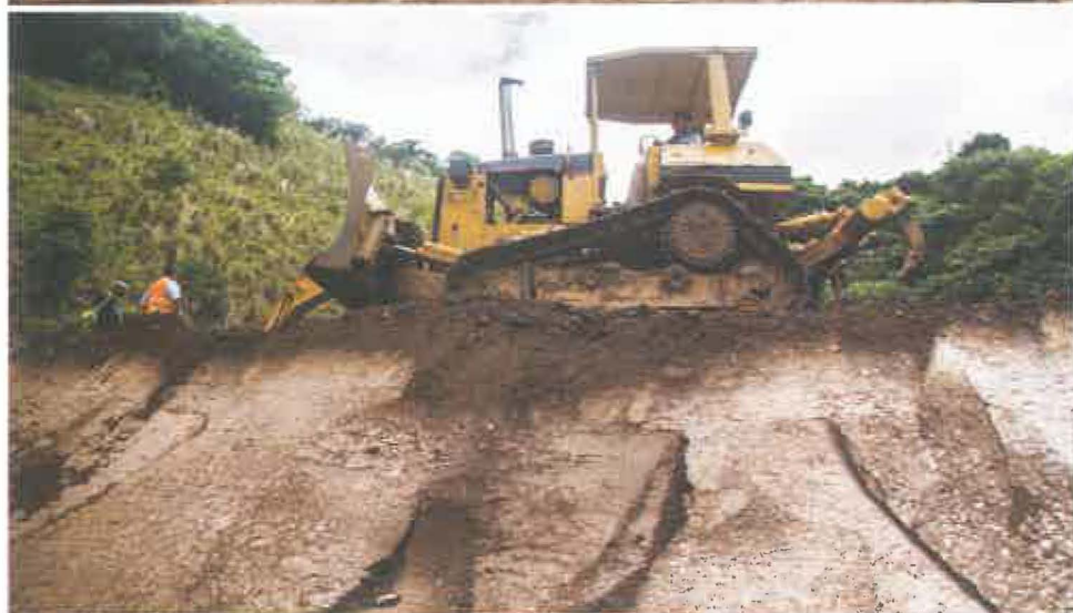
Compactación de la corona con rodillo y tractor de oruga. Fotos: CATIE.
