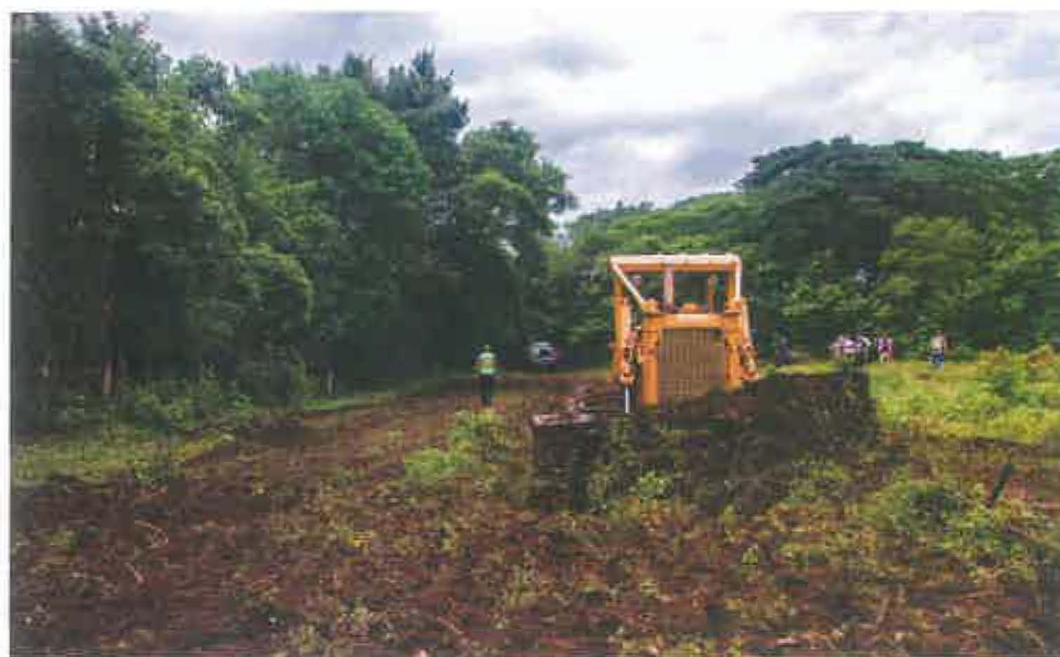
La remoción de las primeras capas de suelo debe hacerse en dirección al talud o dique principal para formarlos con este material removido. Foto: CATIE.
