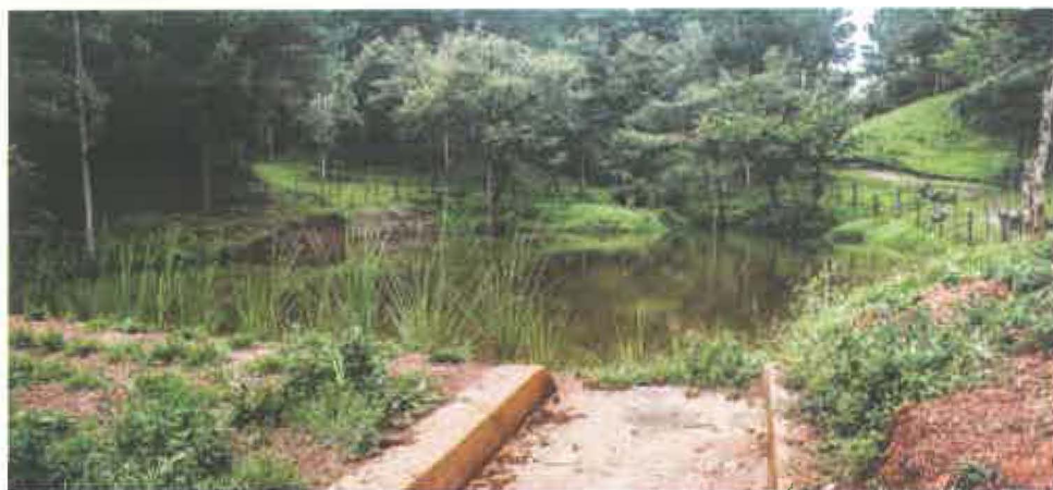
El vertedero de concreto ciclópeo reforzado con piedra de río, puede tener una vida útil de alrededor de 20 años. Foto: CATIE.
