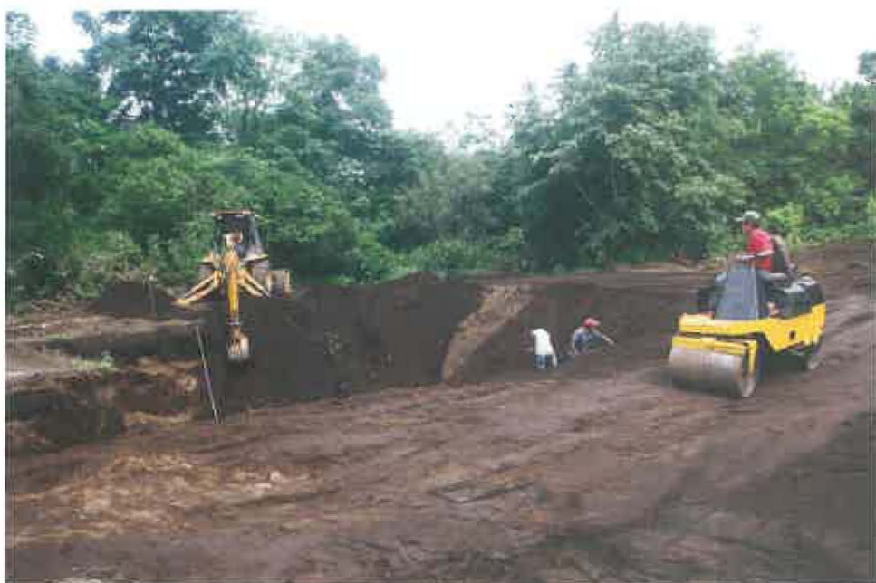
Reservorio construido solamente por excavación del vaso y conformación de taludes y corona. En estos casos, la tierra removida no se utiliza para conformar taludes. Foto: CATIE.
