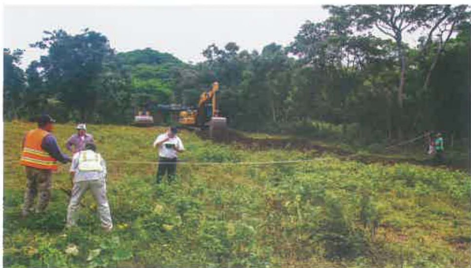
La medición y el trazado se complementan con la colocación de estacas para guiar el trabajo de los constructores de la obra. Foto: CATIE.
