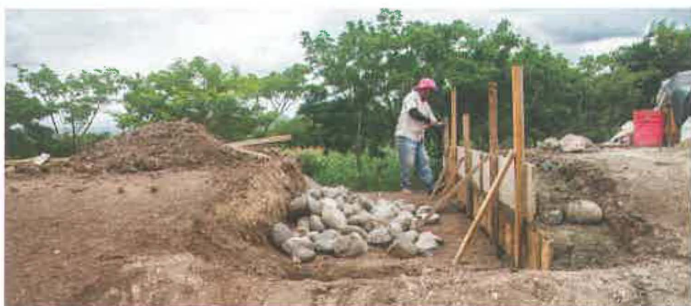
Construcción del vertedero. Fotos: CATIE.
