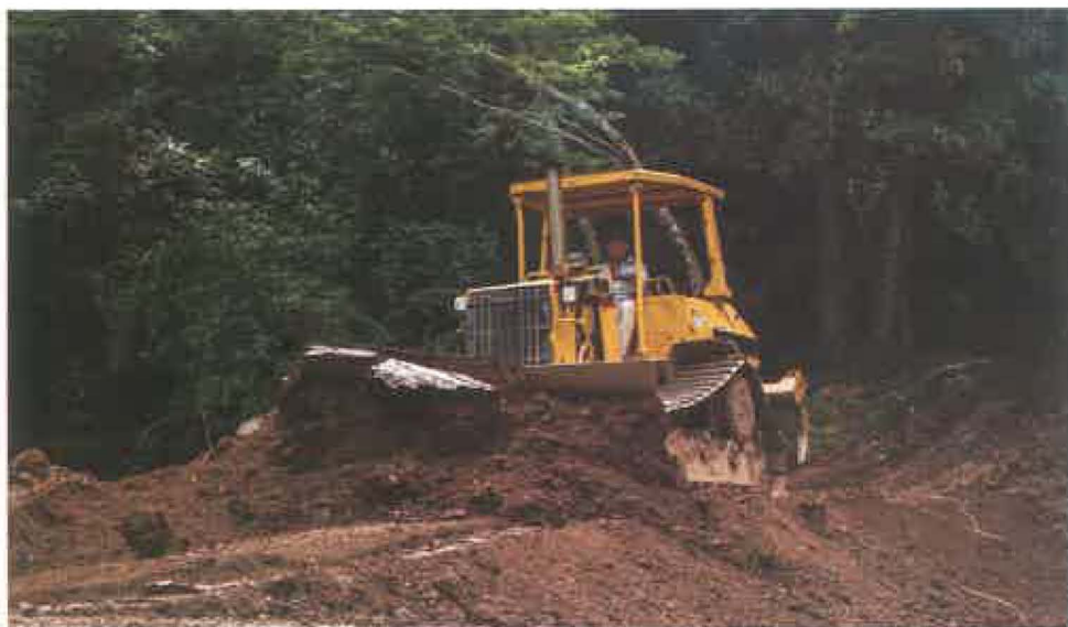
Excavación y formación de taludes con maquinaria pesada. Foto: CATIE.
