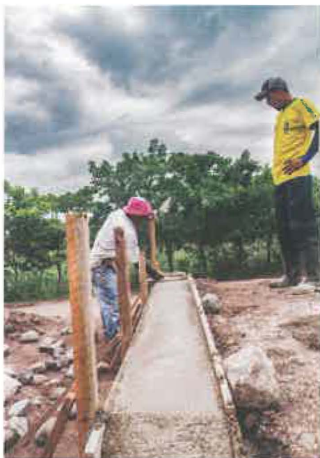
Construcción del vertedero. Fotos: CATIE.
