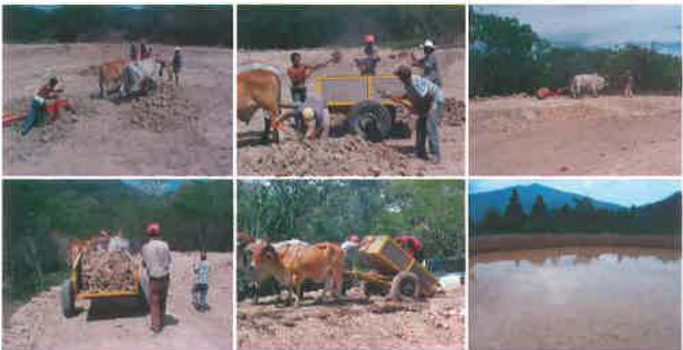
Proceso de construcción de reservorios usando tecnología de tracción animal. Fotos: Red Latinoamericana de Tracción Animal - RELATA-FAITAN-FUNICA.
