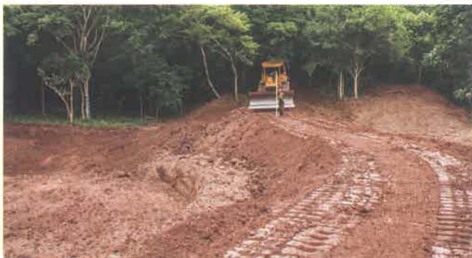
Formación y compactación por capas de la corona con material arcilloso proveniente de la misma construcción del reservorio. Foto: CATIE.
