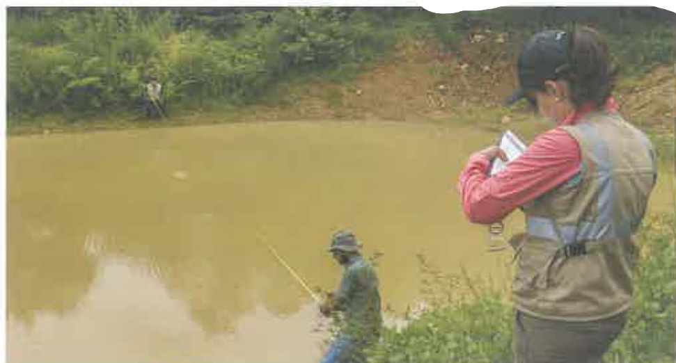
Médción de áreas, revisión de materiales, labores cuidadosamente elaboradas son parte de las acciones previstas para el o la supervisora de la obra. Foto: CATIE.
