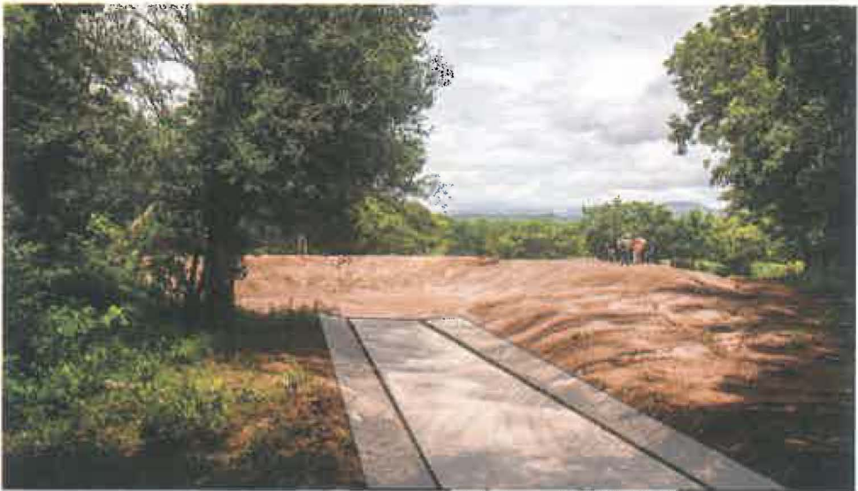
El vertedero se construye en uno de los costados, preferiblemente superiores, del reservorio para evacuar los excesos de escorrentía sin dañar la estructura. Foto: CATIE.
