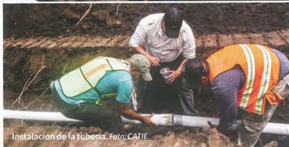
Instalación de la tubería. Foto: CATIE.
