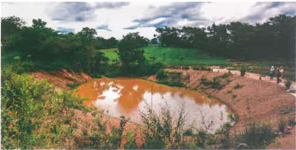
La construcción de reservorios circulares es menos caro, debido a las facilidades que ofrece para el movimiento de la maquinaria. Foto: CATIE.
