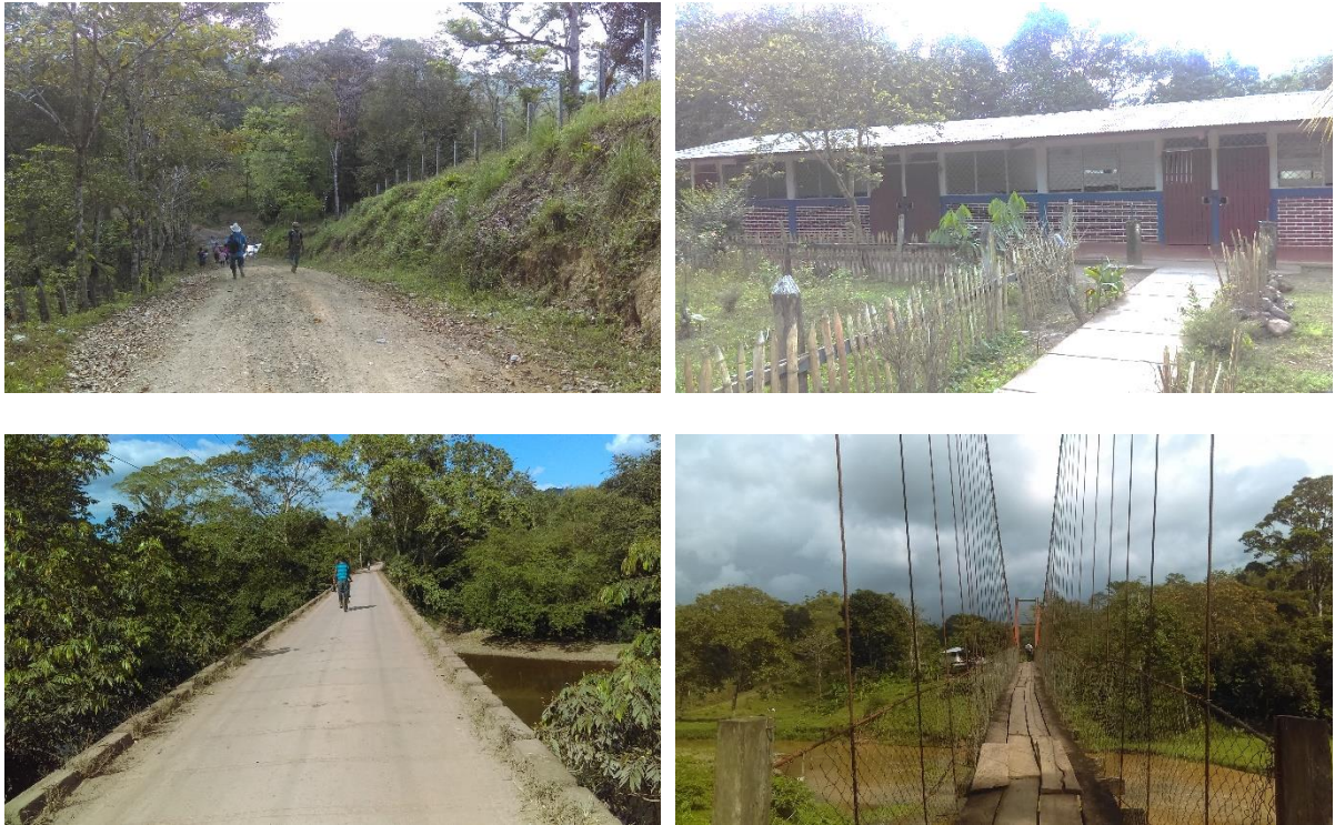
Figura 25 Arriba Izq. Carretera rural con gran pendiente. Der. Escuela primaria en Waslala. Abajo Izq. puente vehicular en Siuna. Der. puente peatonal en Waslala.
