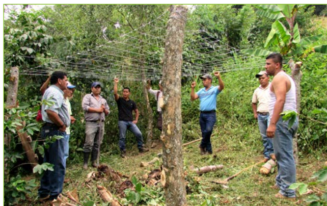
Construcción de enramada o espaldera tipo cuadro (Foto: S. Taleno).
