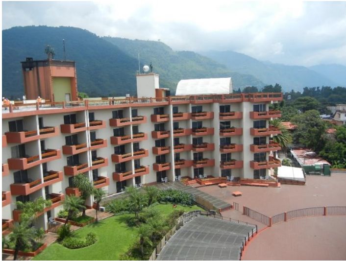
Figura 29. Edificio de habitaciones
