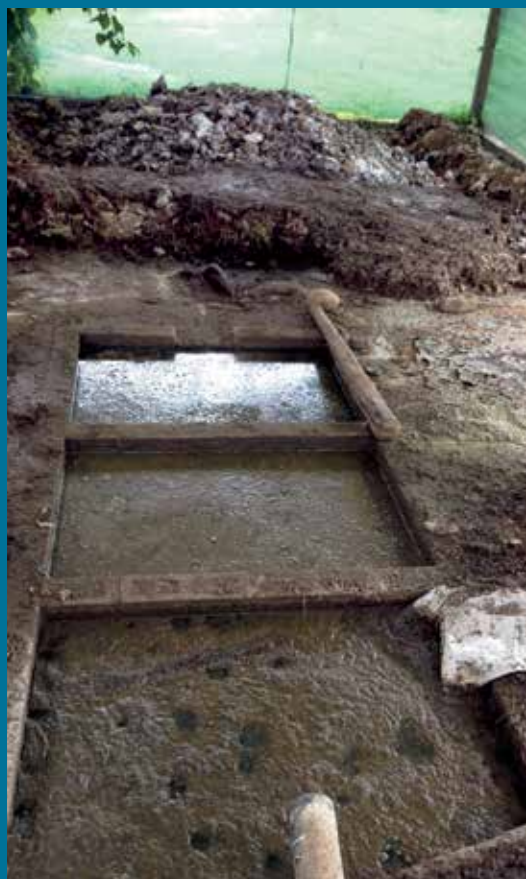
Tanque separador de sólidos en pequeñas y medianas explotaciones lecheras.
