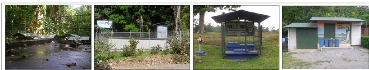
Figura 3. Principales estructuras del acueducto de la ASADA de Suerre. De izquierda a derecha: obra de captación, tanque de almacenamiento, quiebra gradiente e hidrante y oficina- bodega.
