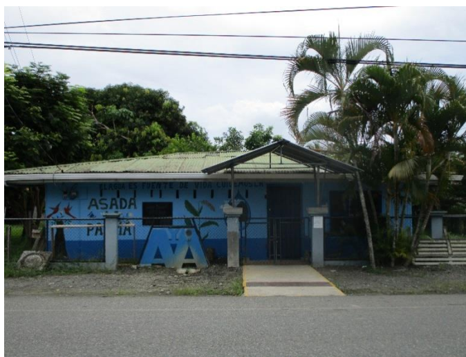
Figura 8. Instalaciones de la ASADA en la comunidad de La Palma
